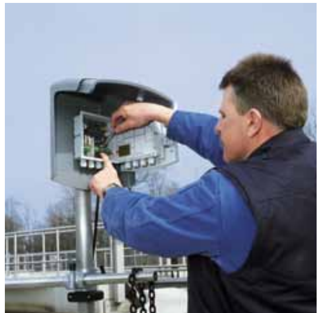
Instalación simple en el tanque de procesos (in-situ)
